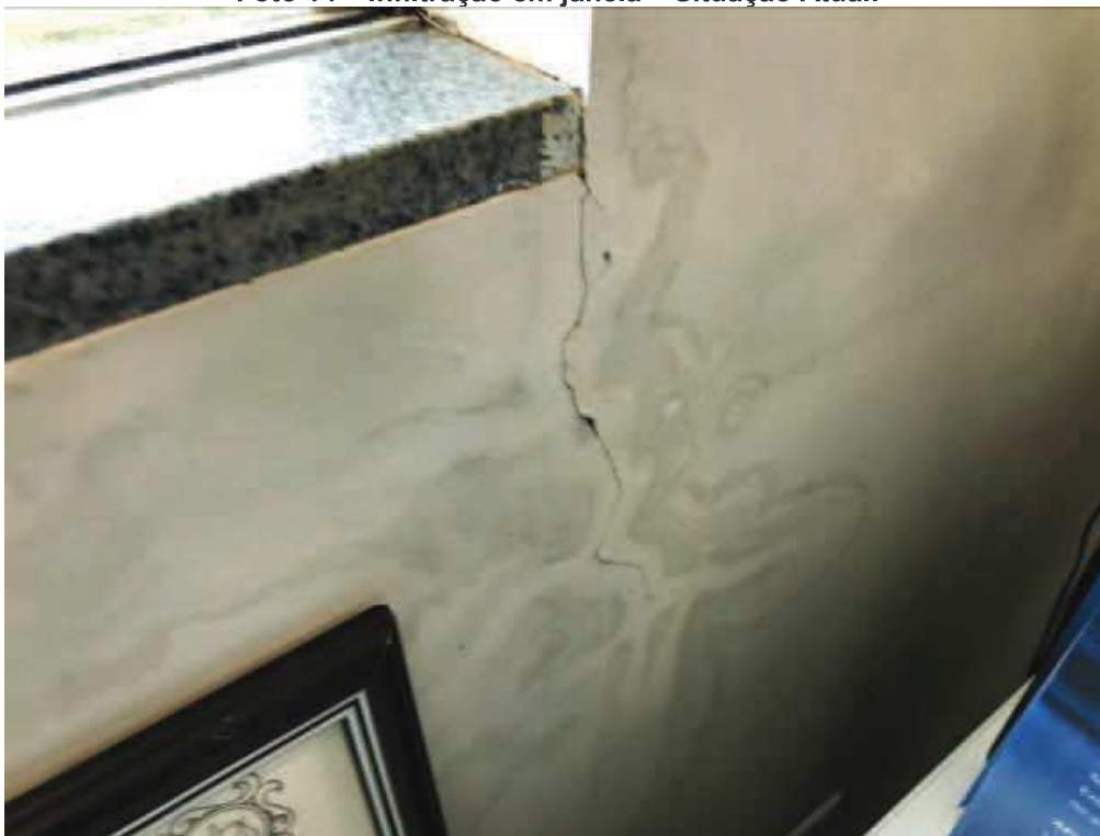
Foto 14 – Infiltração em janela – Situação Atual.
