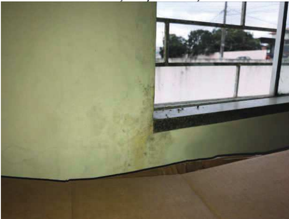
Foto 16 – Infiltração em janela – Situação Atual.
