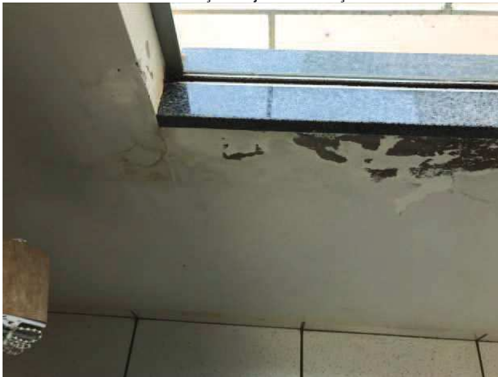
Foto 15 – Infiltração em janela – Situação Atual.
