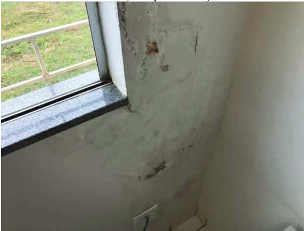
Foto 13 – Infiltração em janela – Situação Atual.
